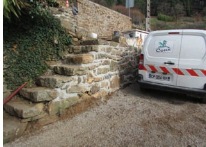
▲ Réfection d'un mur en pierres au quartier Masneuf
