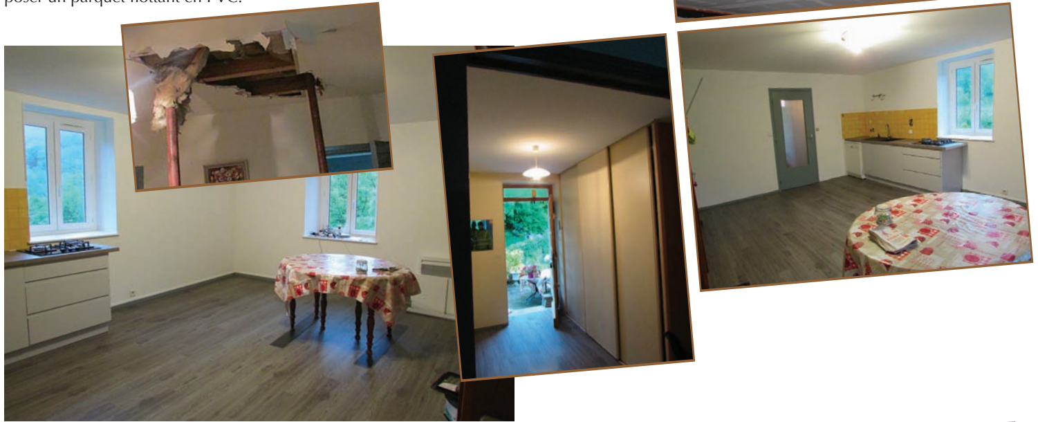
▲ Rénovation logement Le Mûrier
