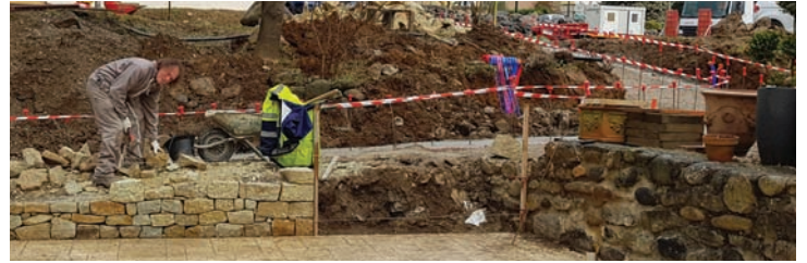
▲ Réalisation d'un muret Place d'Onclaire ▲
