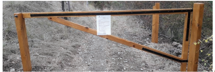
▲ Réalisation et pose d'une barrière ▲
