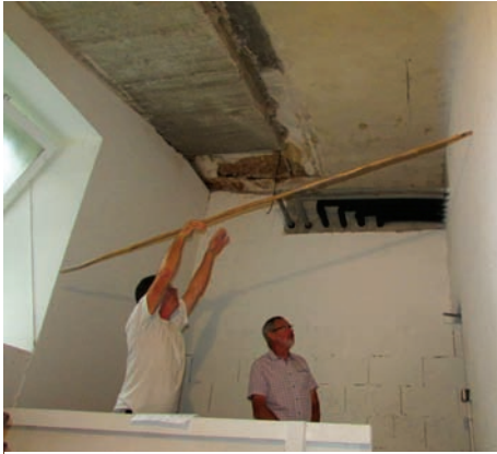
▲ Rénovation plafond arrière scène du Fabricou ▲
