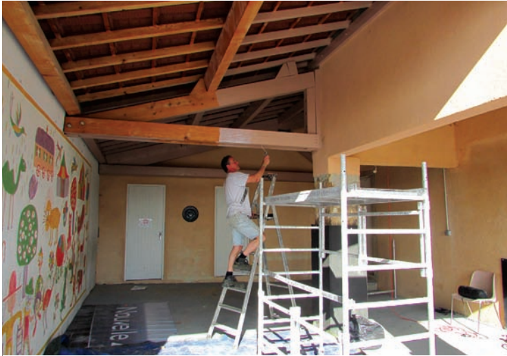
▲ Rénovation de la charpente du préau de l'école de Masneuf ▲
